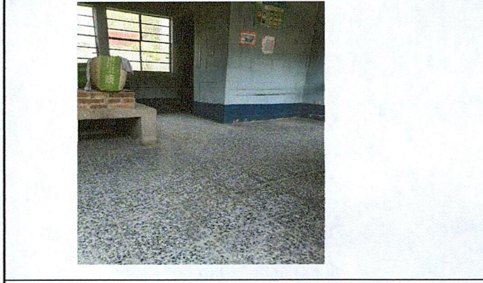
Foto 4: Mejoramiento de piso a la cocina
